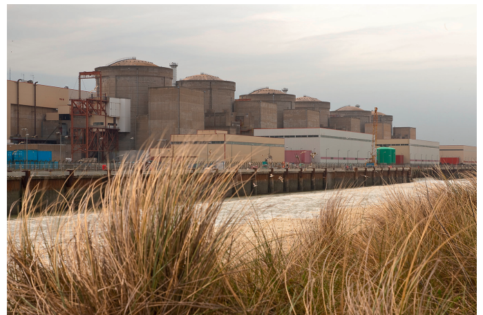
La centrale nucléaire de Gravelines, Nord
