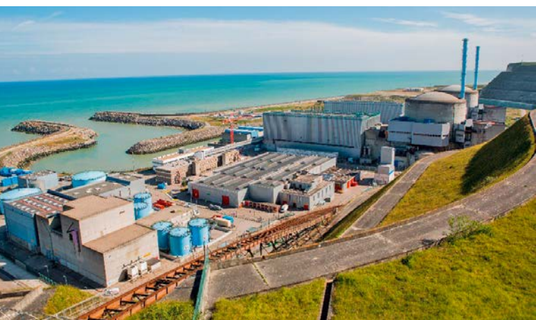
Vue d'ensemble des installations du CNPE de Penly Seine Maritime
