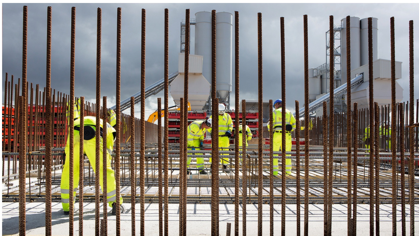
Chantier de construction des deux EPR à Hinkley Point C
