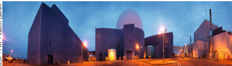
Vue extérieure de l'actuelle centrale nucléaire de Sizewell B
