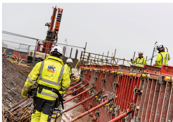
Chantier de construction des deux EPR à Hinkley Point C
