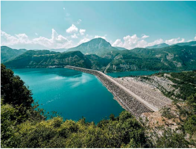
Vue amont du barrage de Serre Ponçon, lac de retenue, remblai et poste de transformation en sortie de la centrale hydroélectrique
